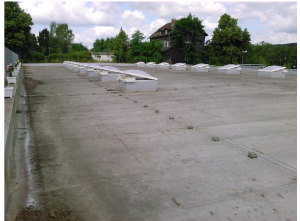
Abbildung 3 Dach des Elektromarktes (Q: DSK)
