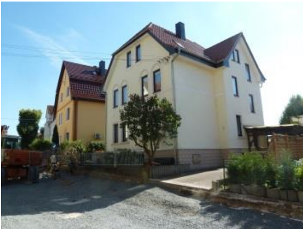
Abbildung 20 Wohngebäude (Q: DSK)
