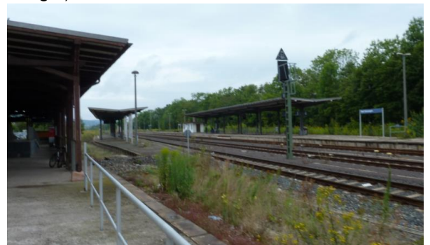
Abbildung 7 Gleisbereich hinter dem Bahnhofsgebäude (Q: DSK)
